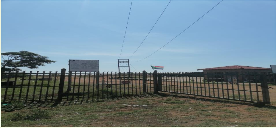
4.9.5 LANDFILL DISPOSAL AREA (BEFORE)
